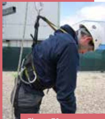
Figura 70. Trabajador colgado de un arnés sujeto por anclaje dorsal
