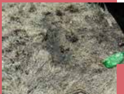
Figura 57. Conato de incendio, fuego de pequeña intensidad
